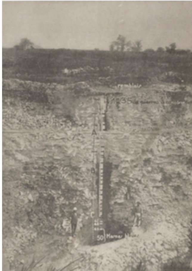
Société des Chaux et Ciments du Sénégal. Dispositif montrant la division en 50 couches du fond de faille de la carrière. (Calcaires en bancs de marnes.)
